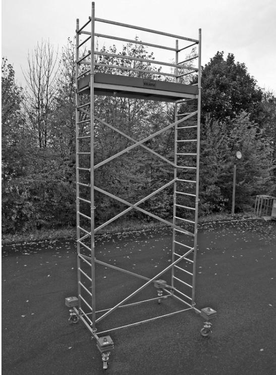
Здесь изображены полностью смонтированные подмости с высотой рабочей площадки 4,3 м.
