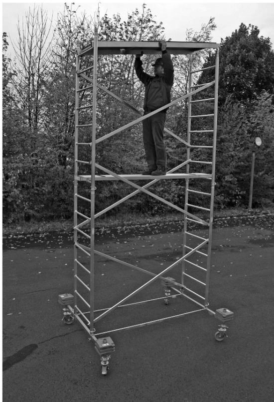
Затем навесьте помост предназначенными для этого пазами на верхние перекладины вертикальной рамы. Крепко затяните ранее установленные страховочные зажимы.
