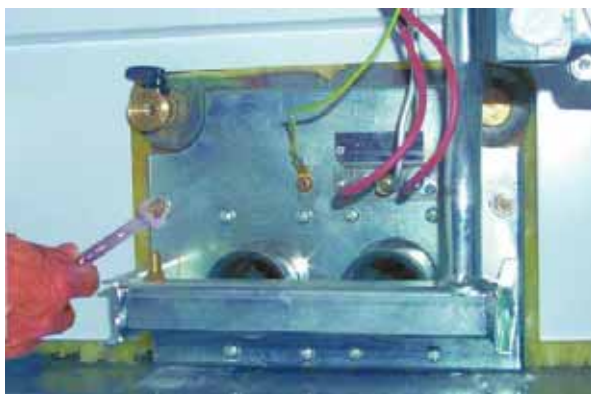
рис. 23 - Демонтаж горелок
