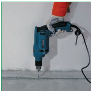
▲ Просверлить отверстие
