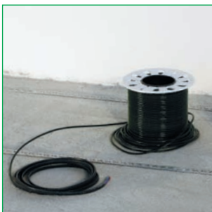
▲ Монтажная лента уложена
