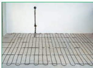
◀ Начало укладки кабеля Весь кабель уложен ▼
