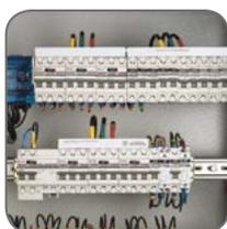
Изготавливаются со степенью защиты IP31 и IP54, что позволяет использовать их в качестве оболочек как для силовых шкафов без специальных требований по герметичности, так и для высокотехнологичных шкафов управления, требующих степень защиты IP54.
