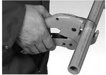
Отрежьте трубу необходимой длины. При помощи графитового стержня обозначить глубину сварки на конце трубы. При необходимости удалить заусенцы и образовавшуюся при резке стружку.
