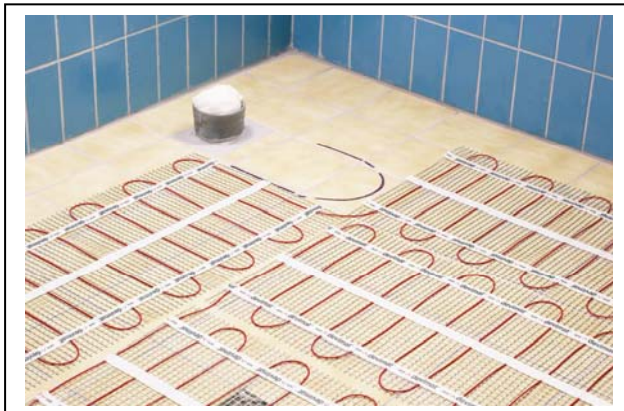
Рис. 3. Монтаж нагревательного мата Devimat™ DTIF в ванной комнате на старую плитку.
